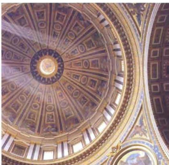
Die doppelschalige Kuppel der Basilika St. Peter ist das größte freitragende Ziegelbauwerk der Welt. Sie hat einen Durchmesser von 42,34 m und wird von vier fünfeckigen Pfeilern mit einem Durchmesser von je 24 m getragen.
