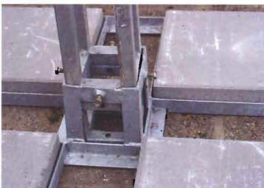
Diese hohen Präsentationstürme werden aufgrund des mächtigen Gewichts der Pflanzschalen durch 4 Betonplatten stabilisiert.
